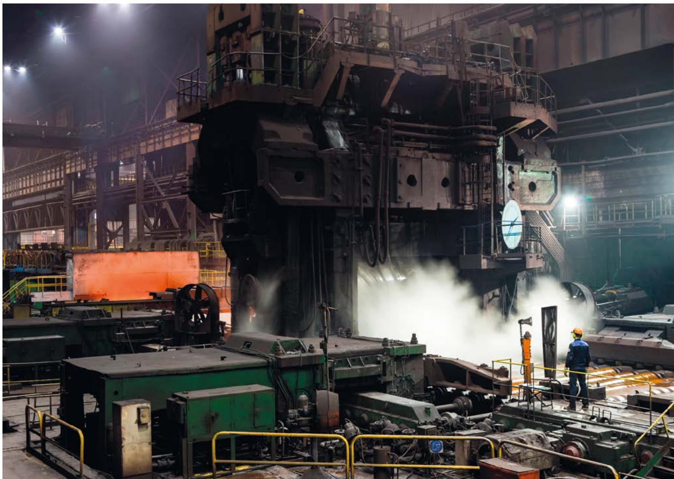
Ремонт стана 5000 в Колпино
