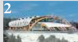
Проектирование и строительство Ледового дворца в Вотчине Деда Мороза (2009-2010 гг.)
