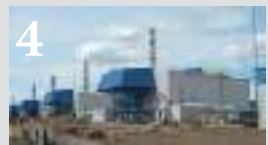
Производство комплексных инженерных изысканий по объекту «КС «Новомикунская», КС «Новоюбилейная», КС «Новоносеницкая» в составе стройки «Система магистральных газопроводов Ухта-Торжок» (I очередь) (2011-2012 гг.)
